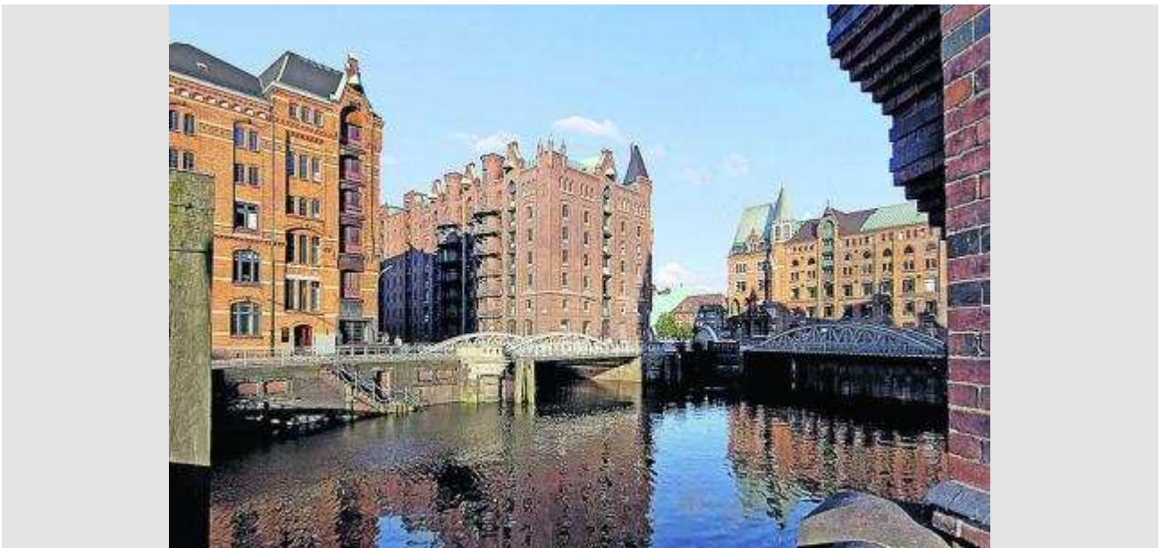
Die Fotos von Thomas Hampel zeigen die Speicherstadt in ihrem städtebaulich-architektonischen Zusammenhang Foto: Speicherstadtmuseum
